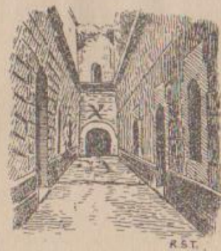
Patio interior del fuerte
